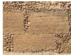
cajas del tapial apeado
