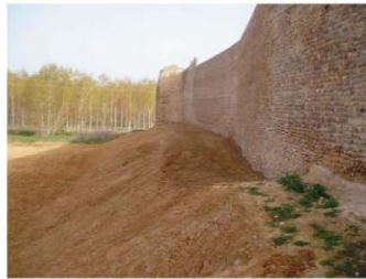
Muralla de las Motas (León), lienzo del extremo oeste antes y después de las recientes obras de restauración
