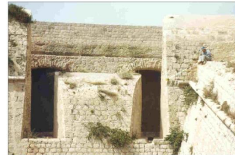
ABOCELADO DE MERLON Y MACHO LATERAL
