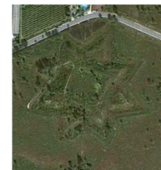
Granda, fortaleza de tierra en la frontera del Miño / forte en terra na fronteira do Miño / earth fort in Miño's border.
